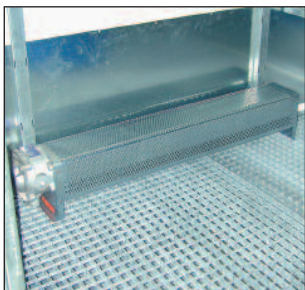
Elektro-Heizung 2 kW, ex-geschützt
