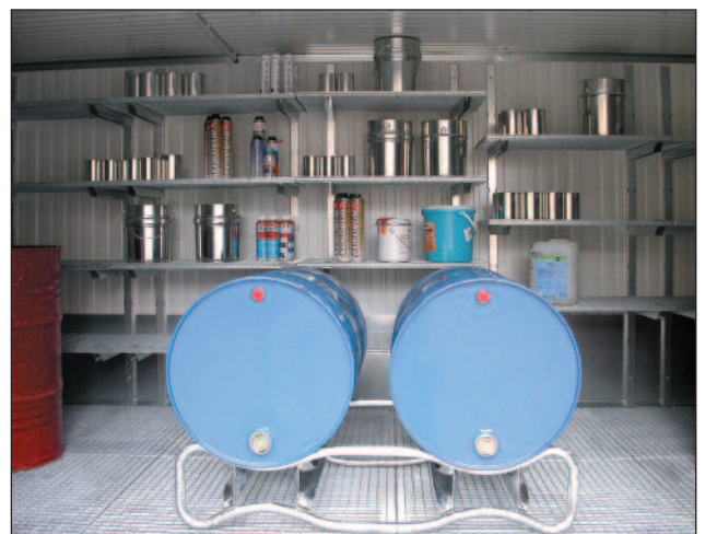
Ausrüstung mit Regalteilen zur Nutzung als Kleingebindelager
