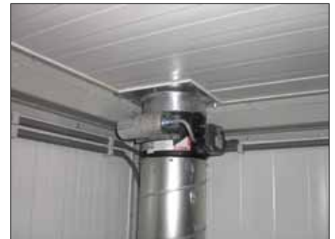
Abluftkanal mit K 90 Absperrvorrichtung
